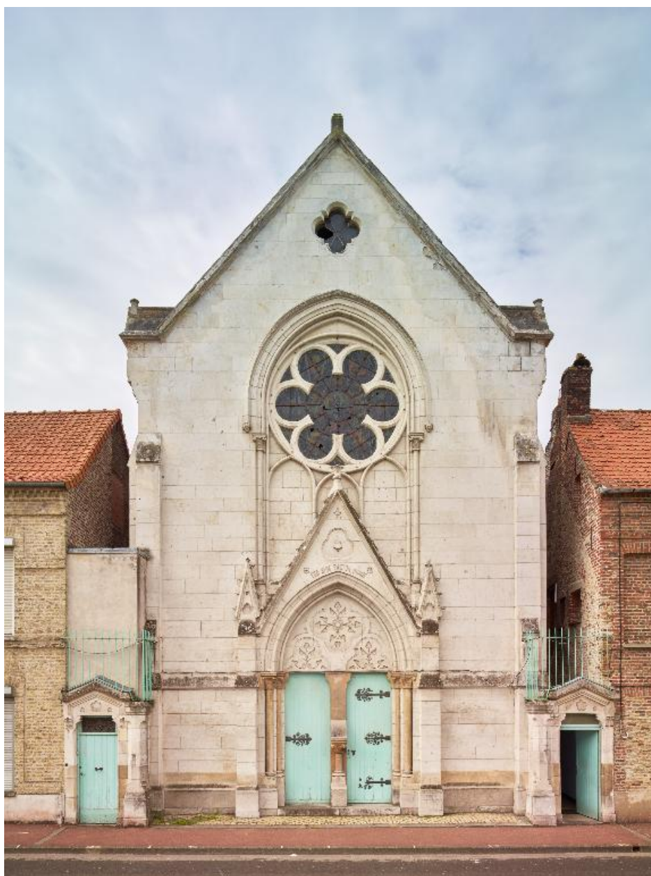
Élévation antérieure de la chapelle.
