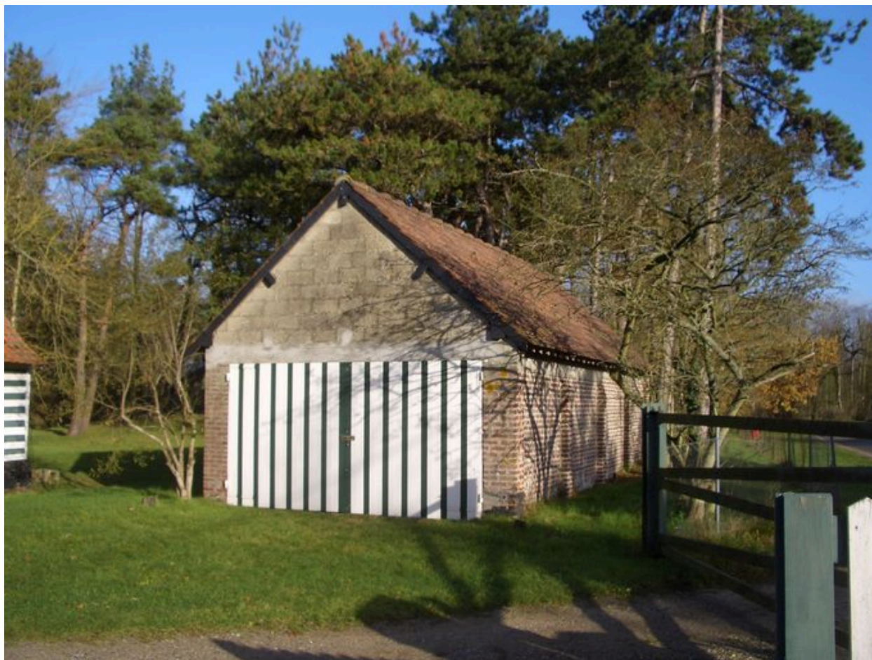
Vue du garage.
