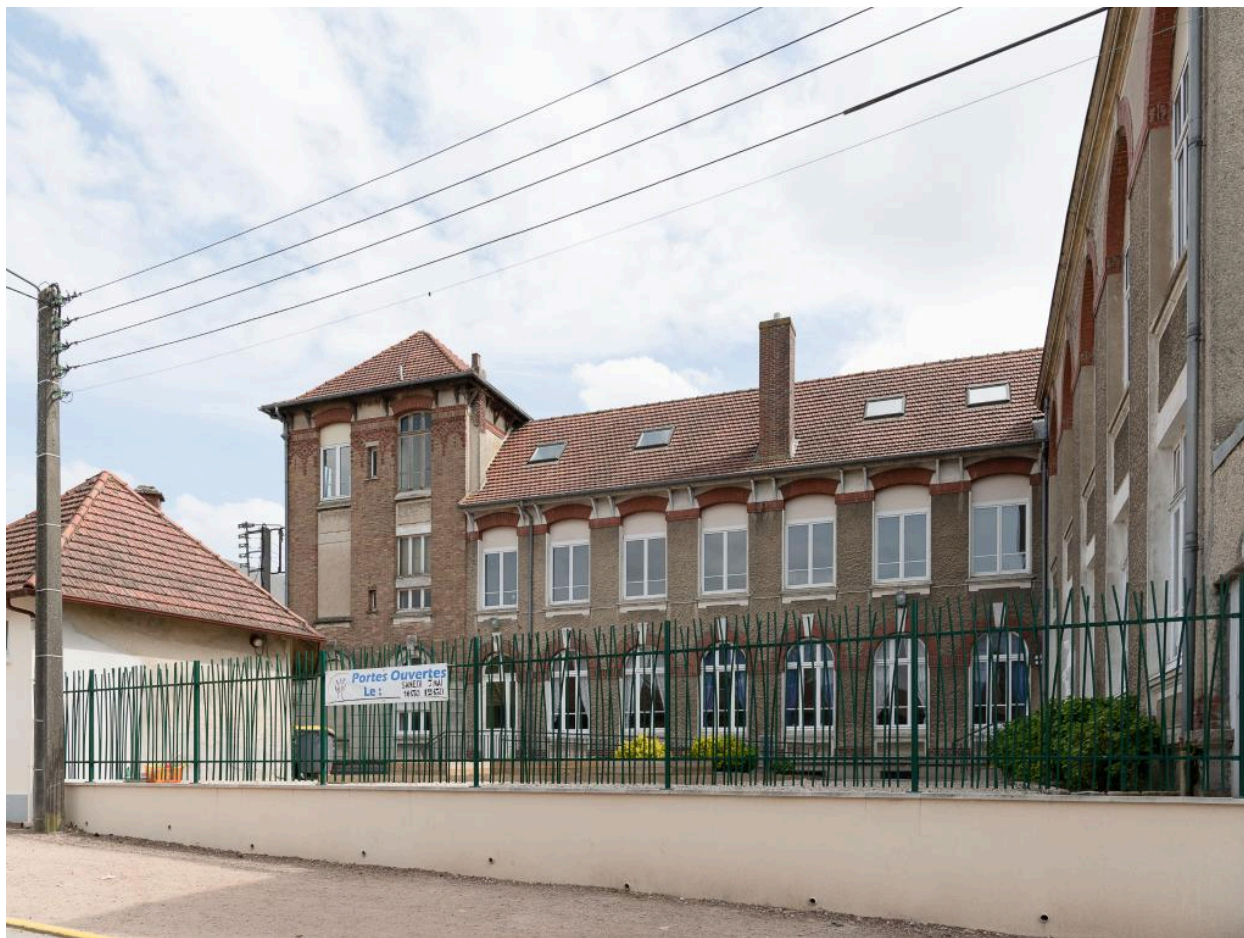
Vue générale depuis la rue du Général-Frère de la façade nord du bâtiment fermant le côté nord de la cour des petits.
