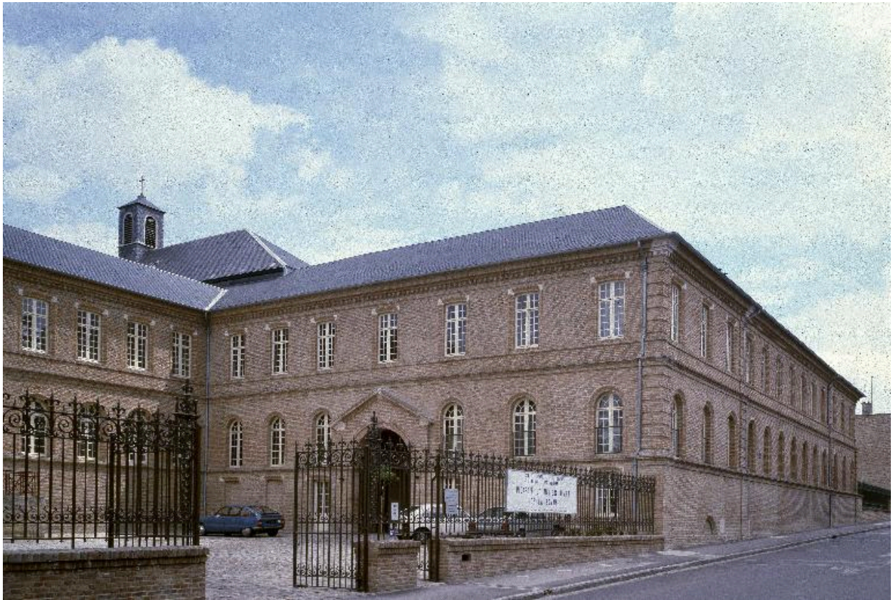
Façades sur la cour d'entrée et sur la rue Saint-Fuscien, en 1984.
