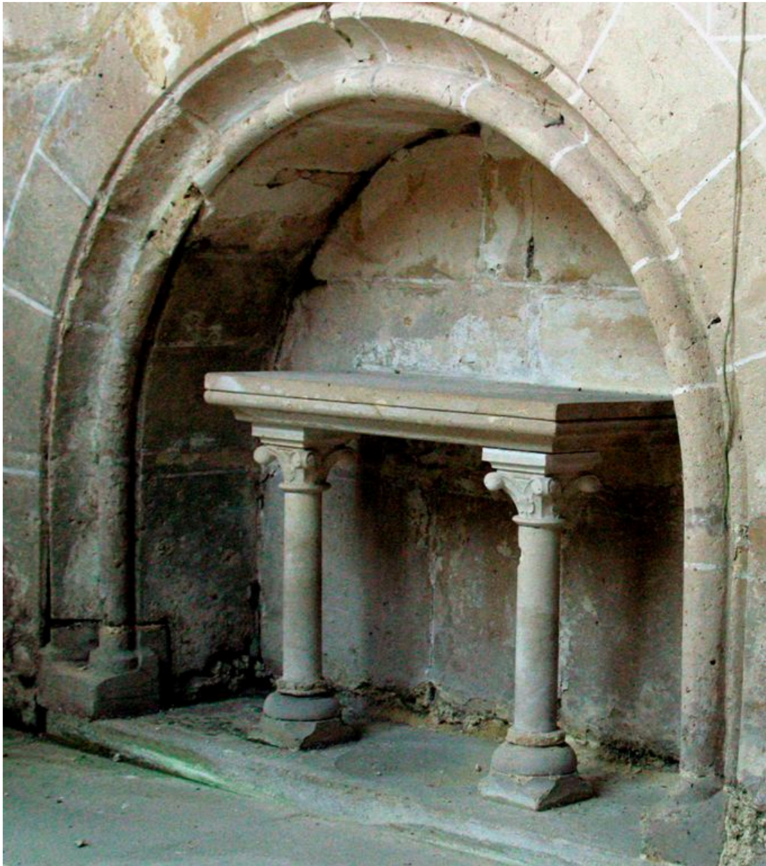
Vue d'une niche-crédence.
