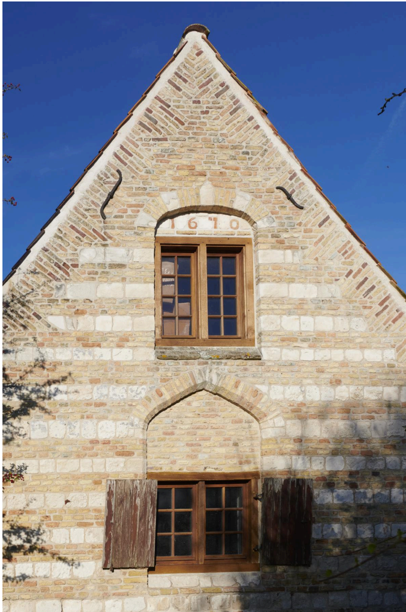
Détail des baies du pignon est. Date portée 1670.
