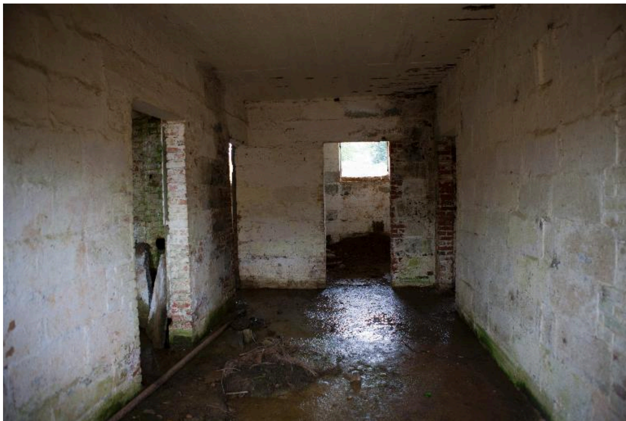
Abri casernement : vue intérieure.
