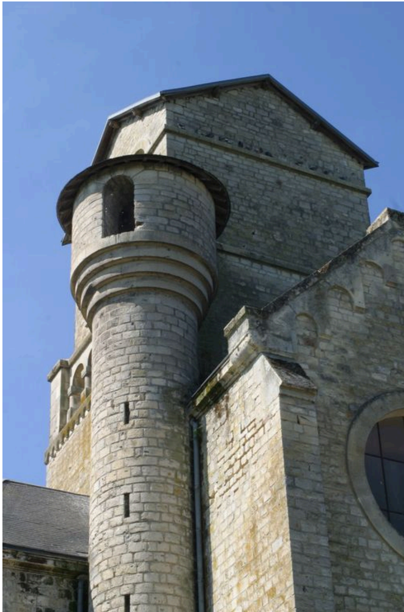
Vue de la tour adossée au clocher.
