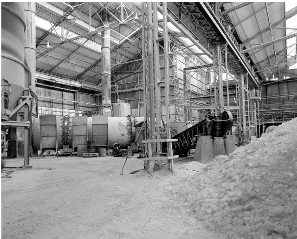
Atelier de fabrication : vue intérieure.
