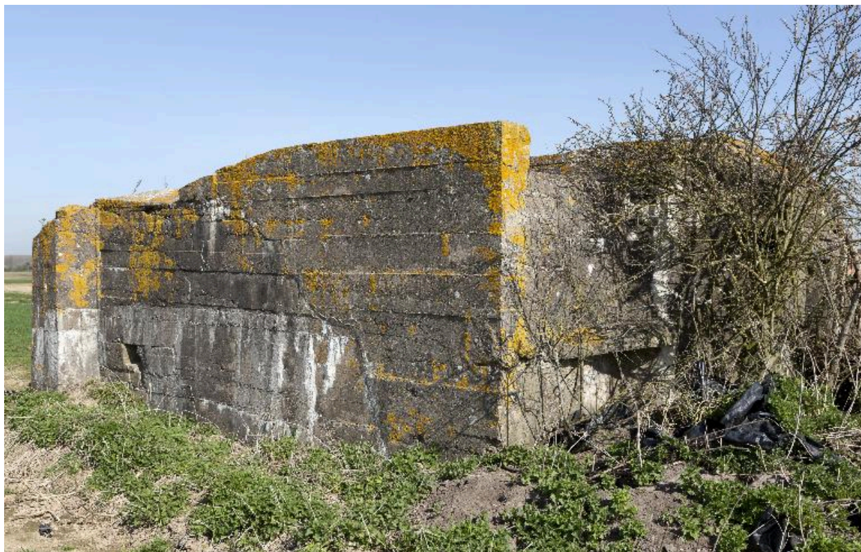
Vue de trois-quarts, vers le nord-est
