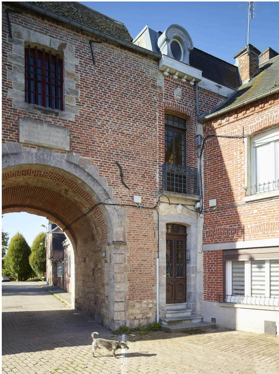
Maison - 50 place Général-Leclerc : la façade sur la place ne compte qu'une travée.
