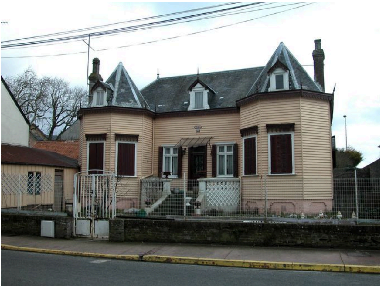
Gros-oeuvre recouvert d'un essentage de planches, villa des Roses, 16 rue Jules Verne (1985 AR 254).
