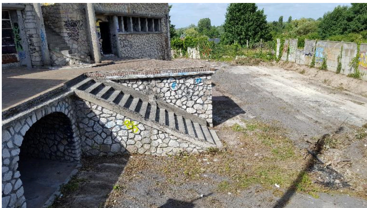
Détail de l'escalier descendant vers les bassins.
