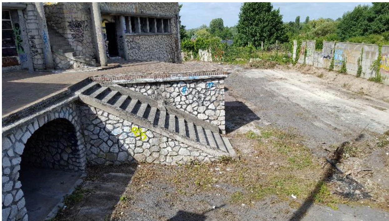
Détail de l'escalier descendant vers les bassins.
