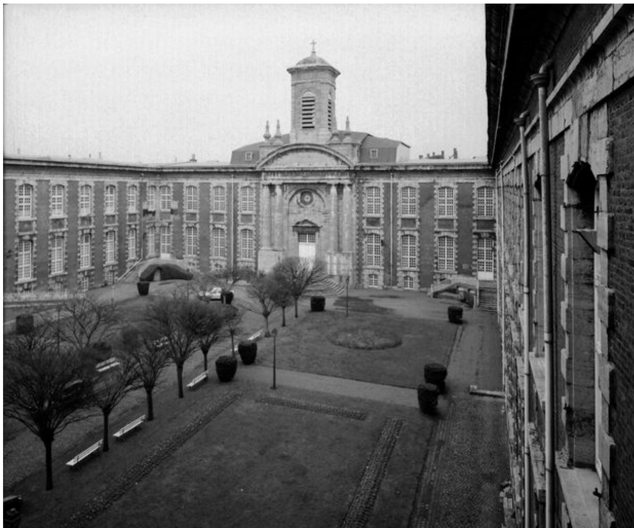
Cour d'honneur, vue générale en regardant vers le corps de bâtiment fermant le fond de la cour avec, au centre, la façade de la chapelle.
