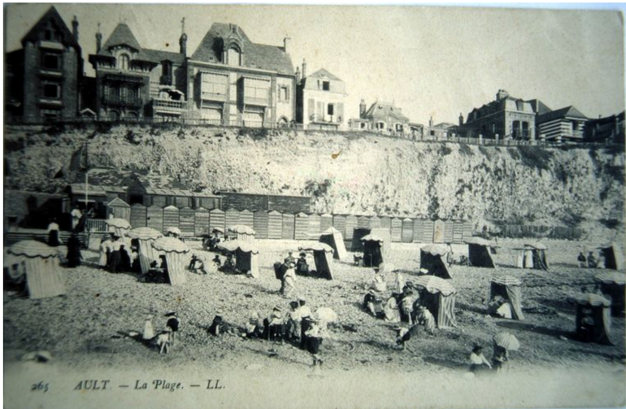
L'établissement de bains chauds derrière la rangée de cabines, par Léon Kämpfer (1880), carte postale, 1er quart 20e siècle (coll. part.).
