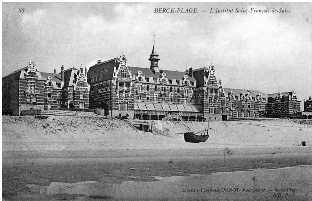
Elévation antérieure, vue générale prise de trois-quarts gauche. Carte postale, début du 20e siècle (coll. part.).
