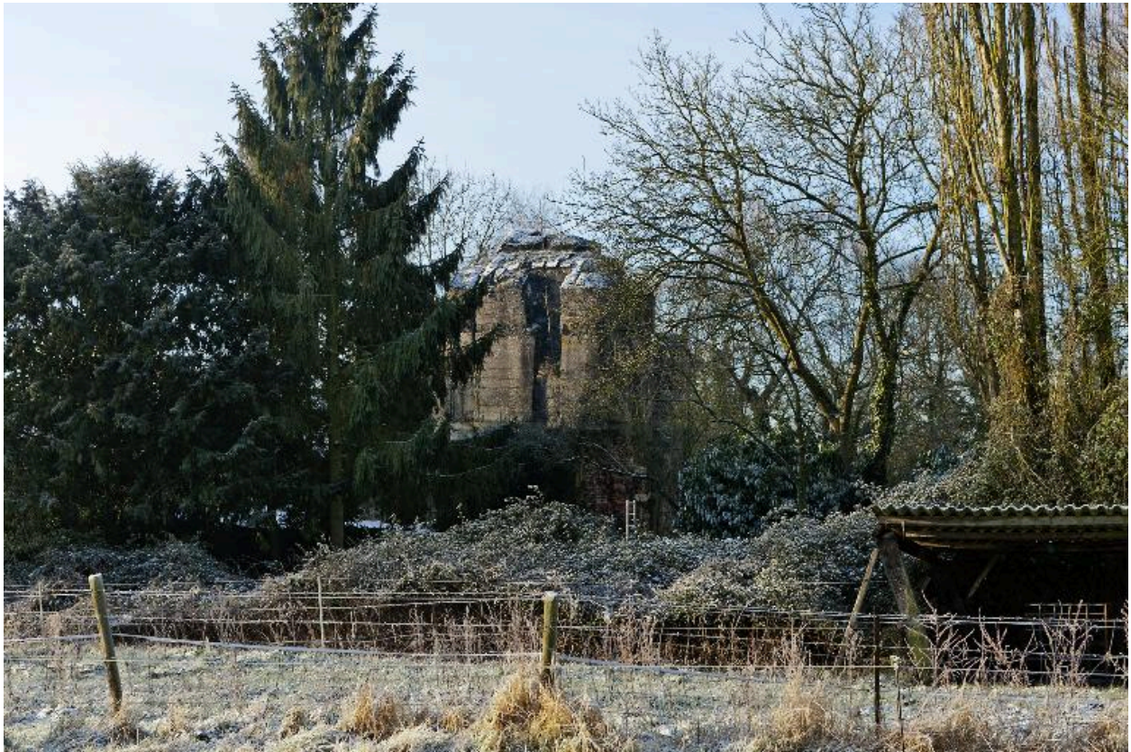
vue générale vers vers le sud
