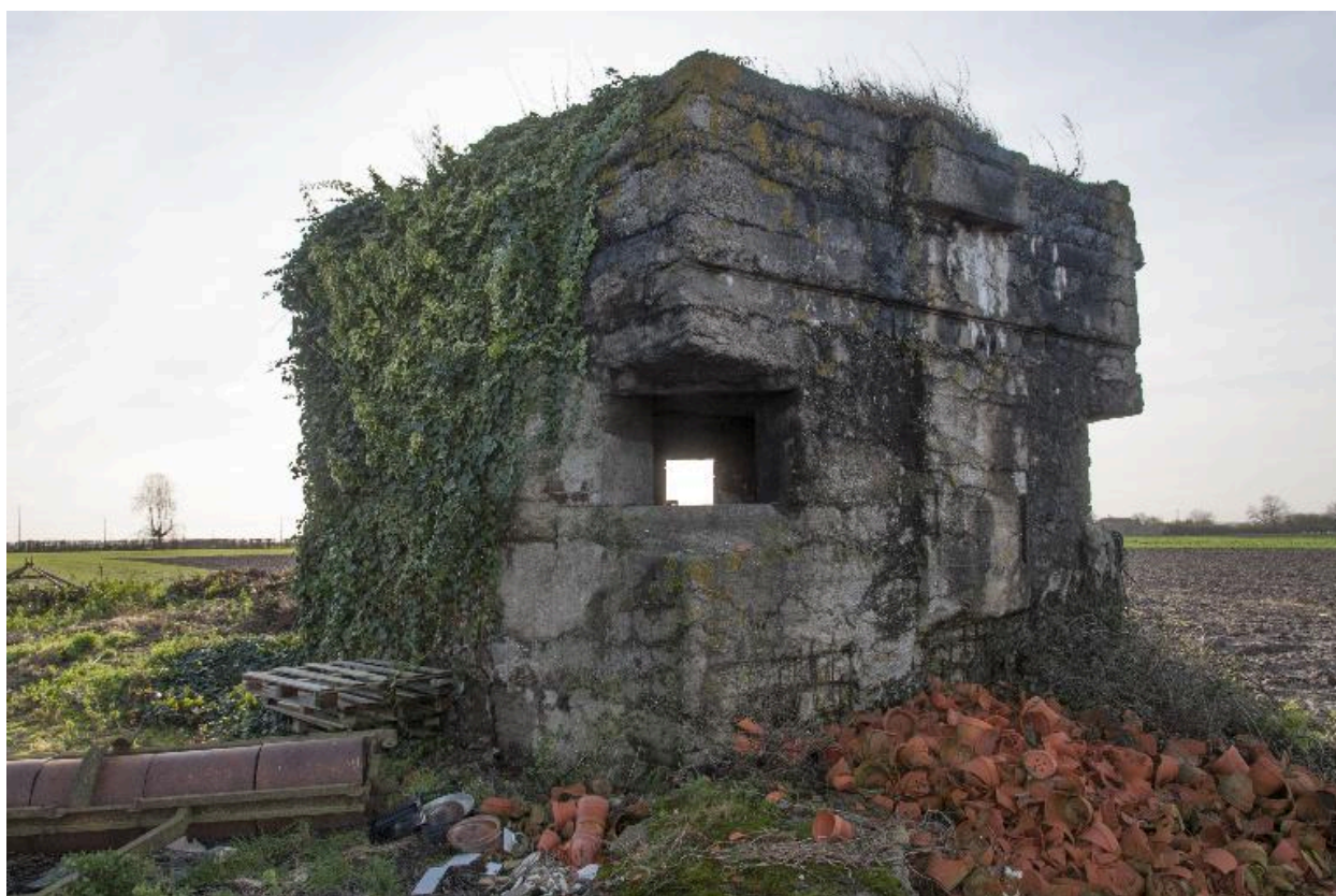
Embrasure de tir située sur l'angle nord-est de l'édifice.
