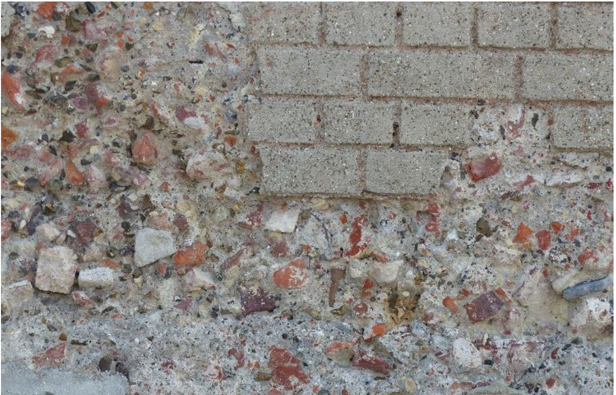
Maison, rue d'Angleterre. Détail de la mise en oeuvre.
