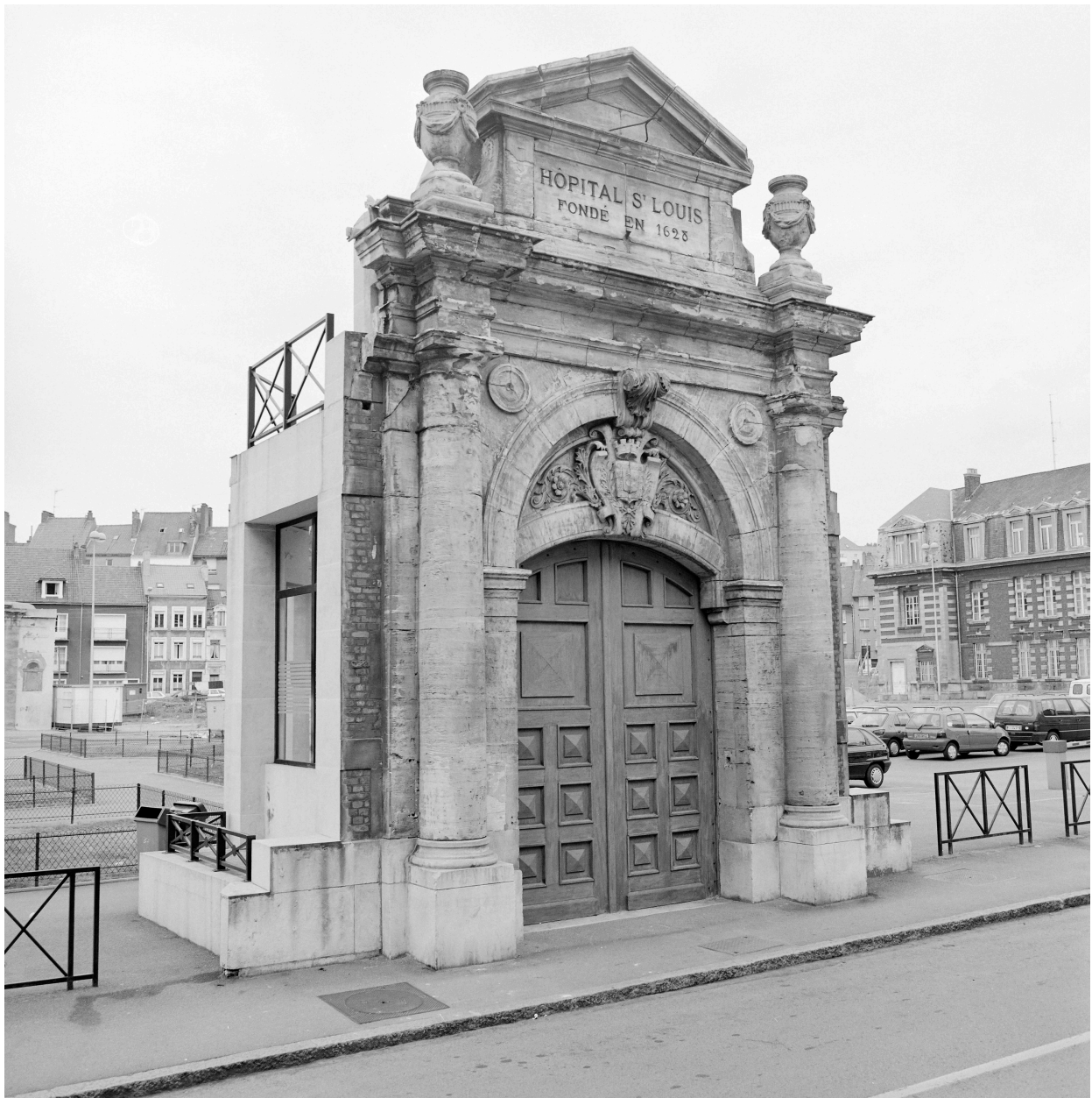
Bâtiment A, portail d'entrée, état en 1994.
