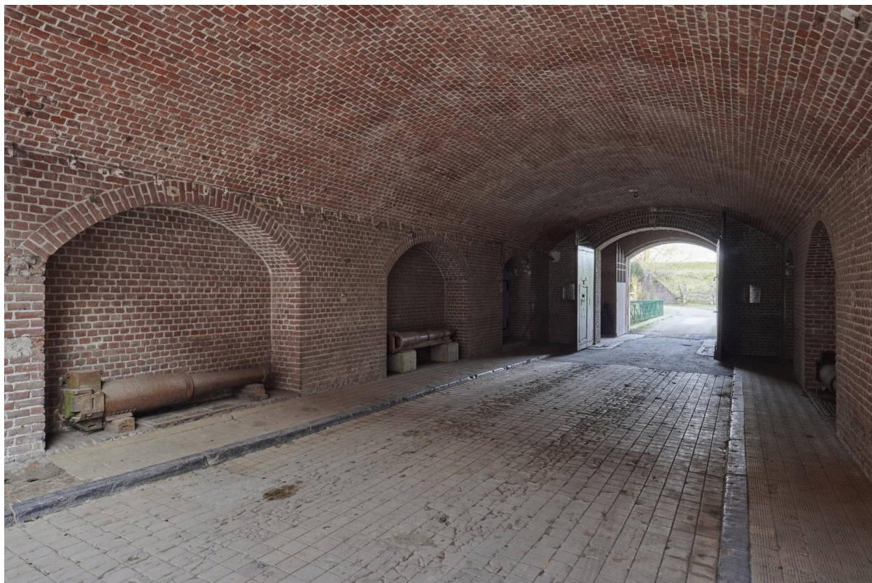
Passage couvert sous la caserne de gorge, vers le nord.
