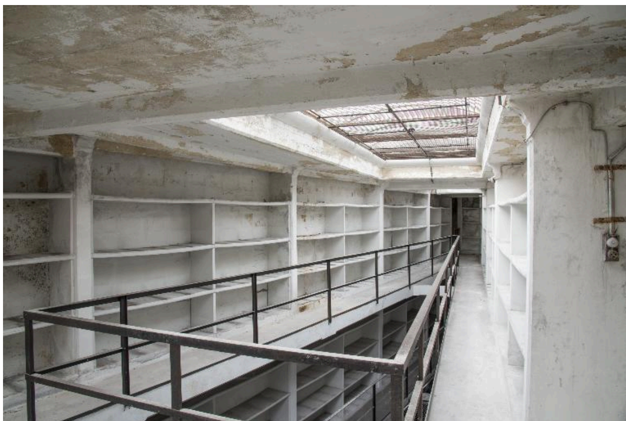
Bâtiment du dépôt, troisième étage : vue du vaisseau 4 vers l'ouest.
