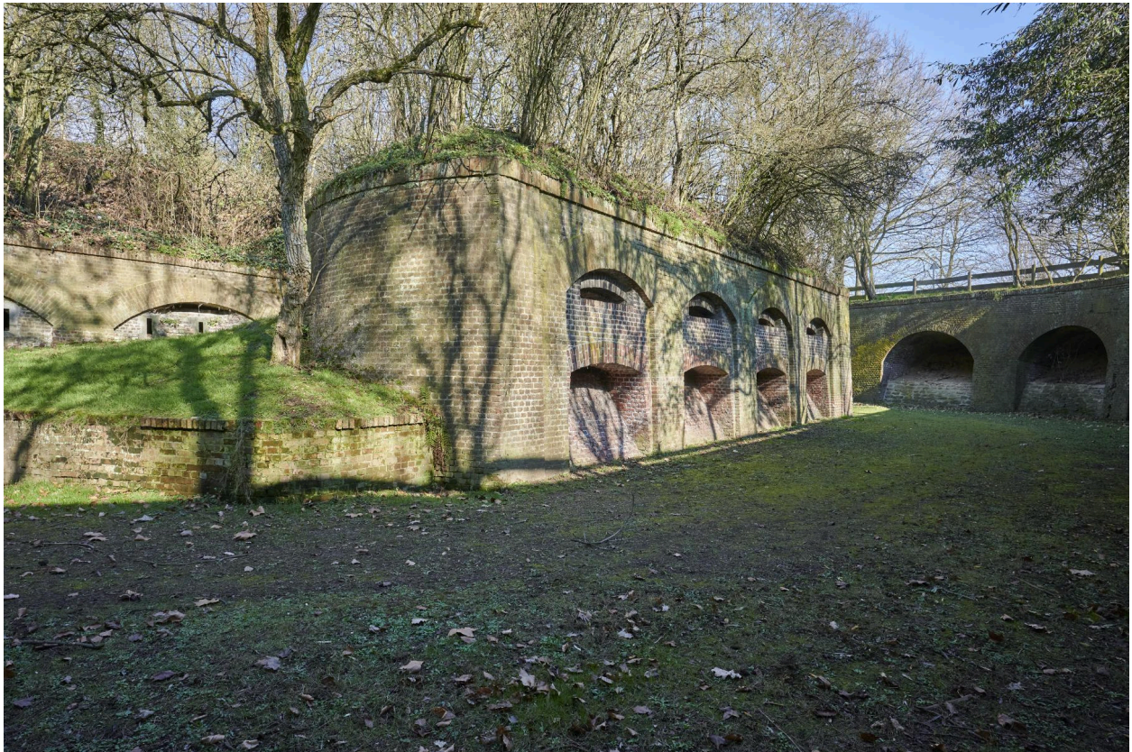
La caponnière simple depuis le fossé sud-est, vers nord.
