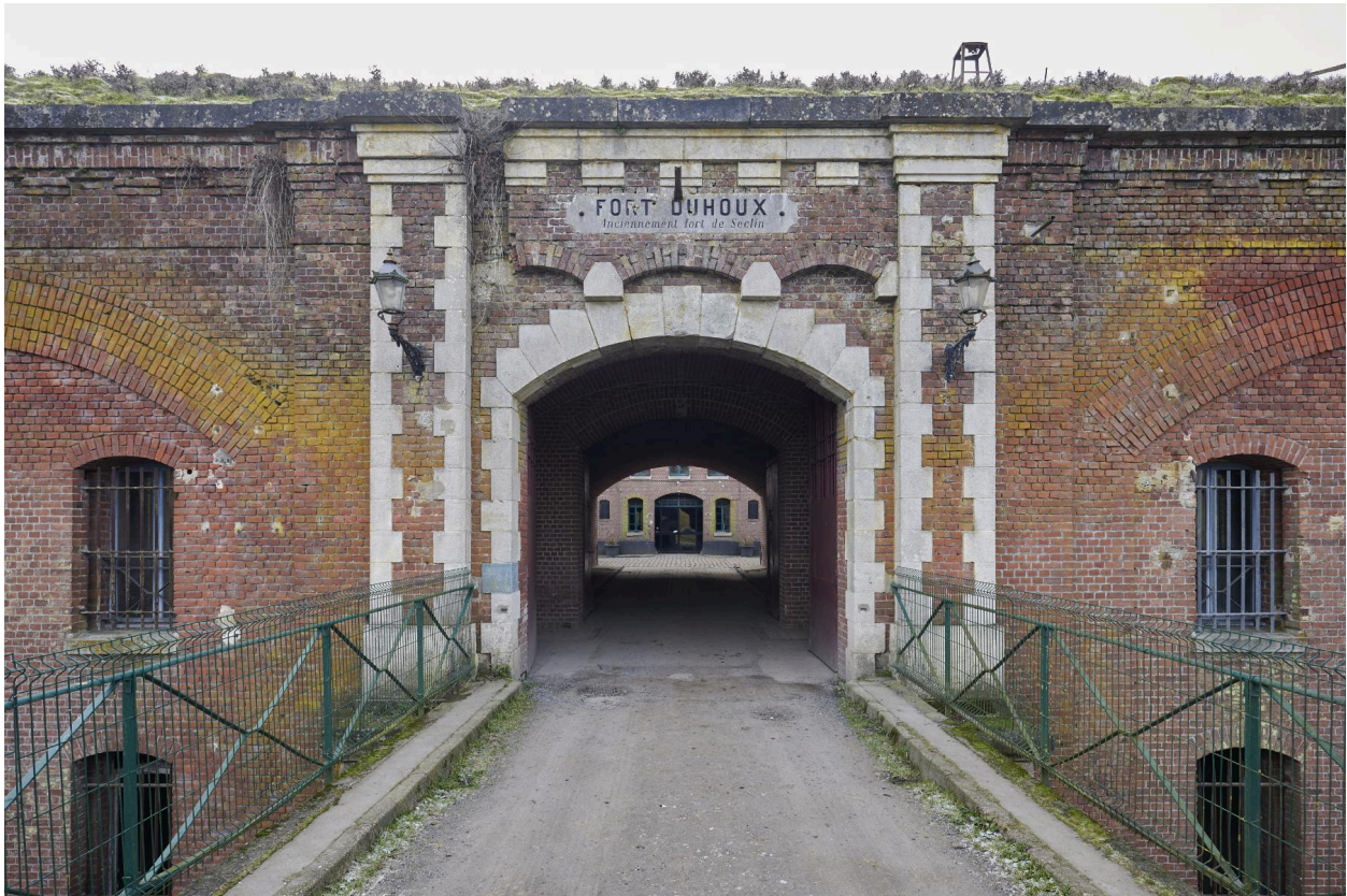
Entrée du fort depuis le pont dormant.
