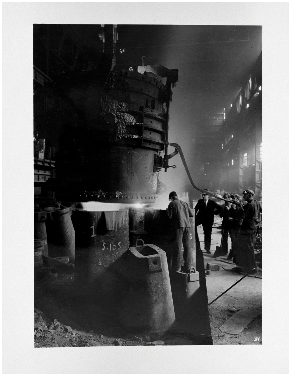
Bassin de coulée de l'aciérie : vue rapprochée de la coulée en lingotières. Photographie ancienne, auteur inconnu, sans date (coll. part.).
