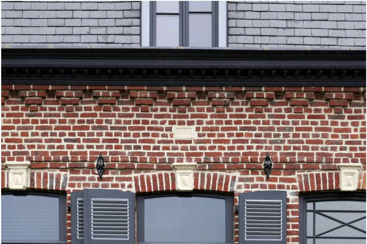
Détail de la date portée et de la corniche.
