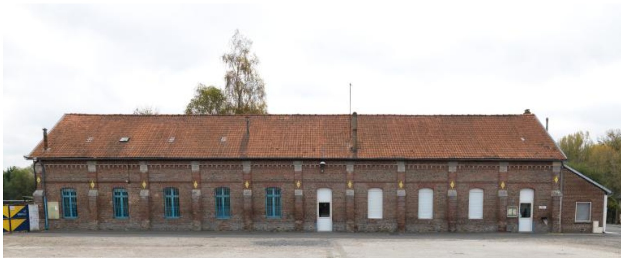
Bâtiment subsistant en fond de parcelle.
