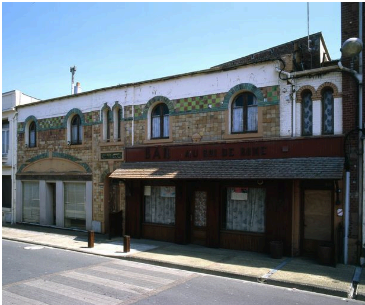
Ancien magasin avec logements à l'étage dit Jehan Gérard (118 et 120 rue de Saint-Valery).
