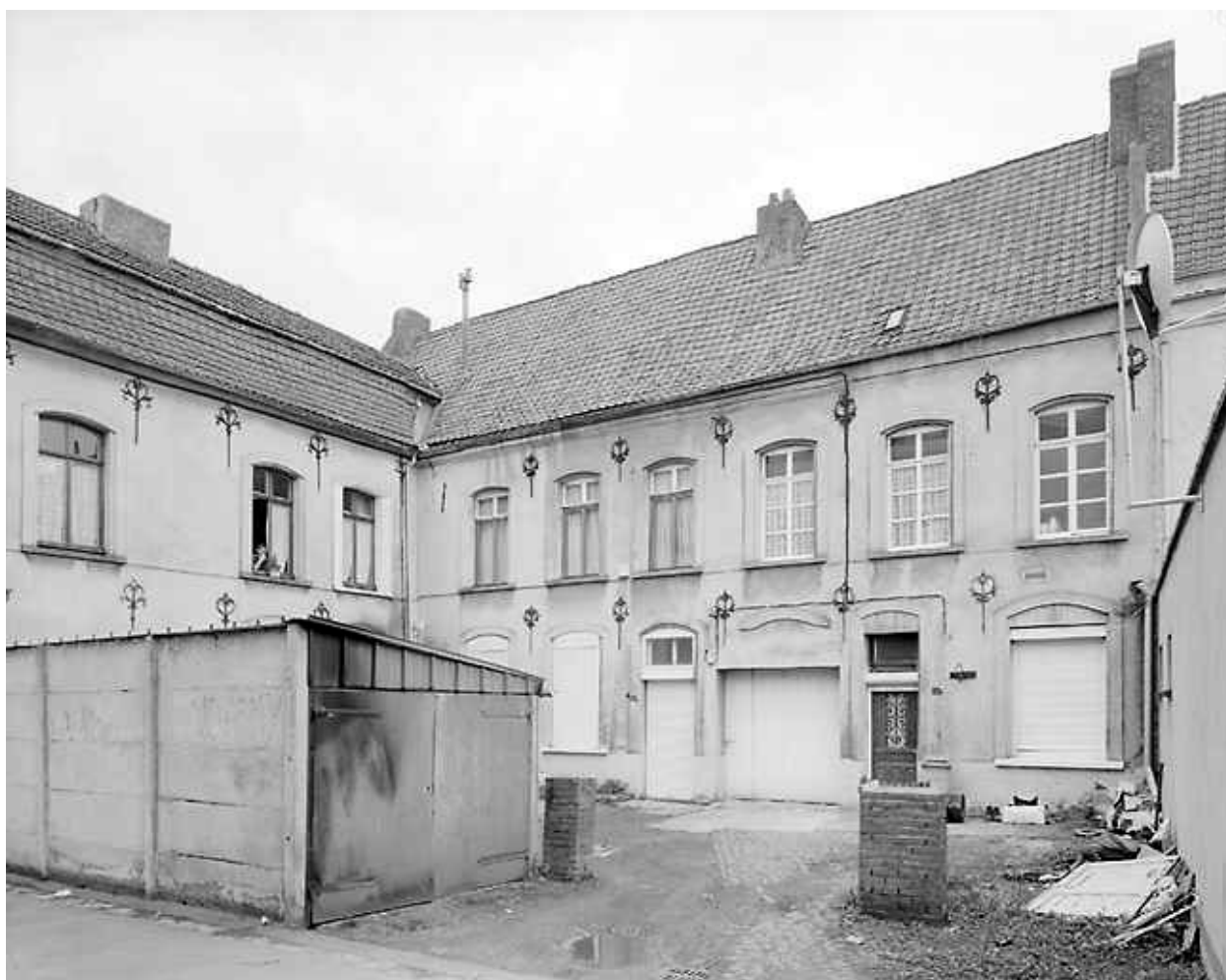
Vue partielle : corps de logis principal, partie gauche, et aile en retour.
