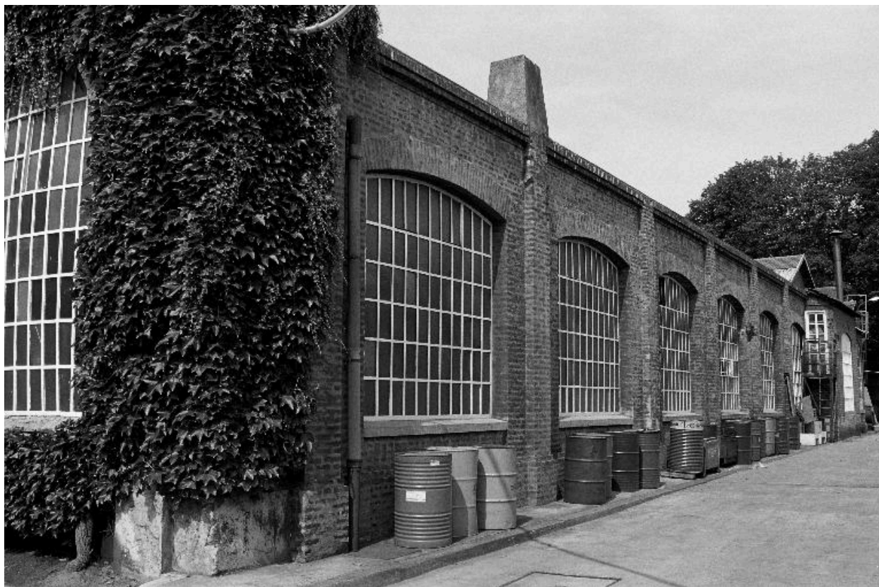
Atelier de fabrication, flanc est, en 1990.
