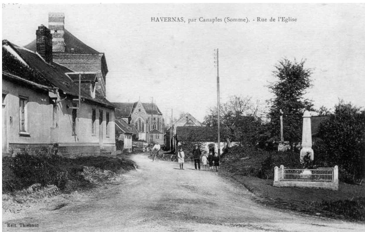
Rue de l'Eglise, 1920-1930 (coll. part.).
