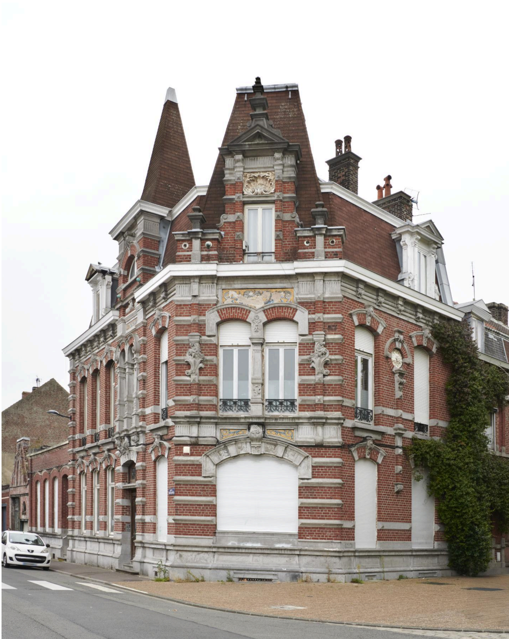
Vue générale de la façade d'angle rue Descartes et place Edouard-Roussel.
