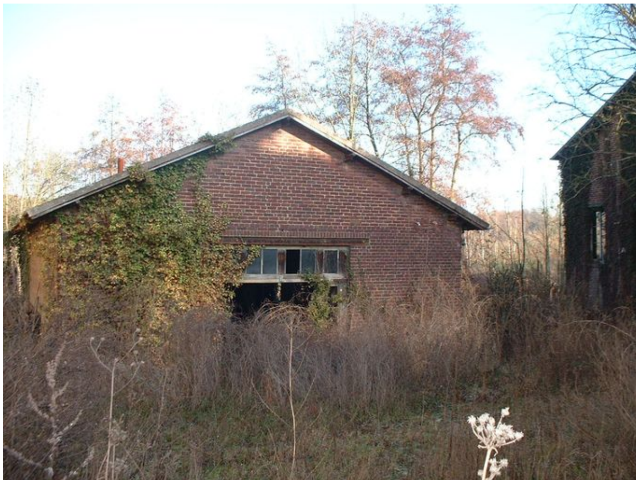
La bâtiment des turbines.
