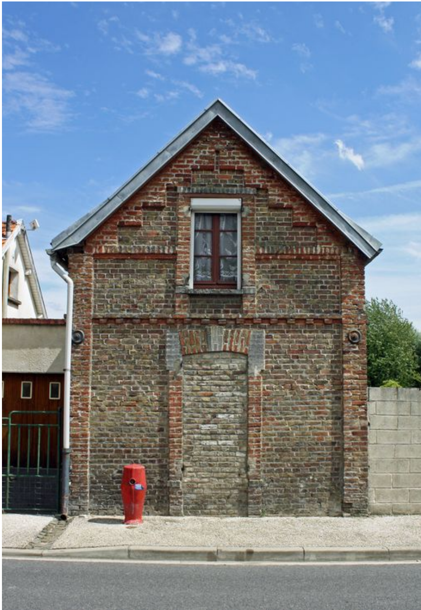
Pignon muré sur la rue.
