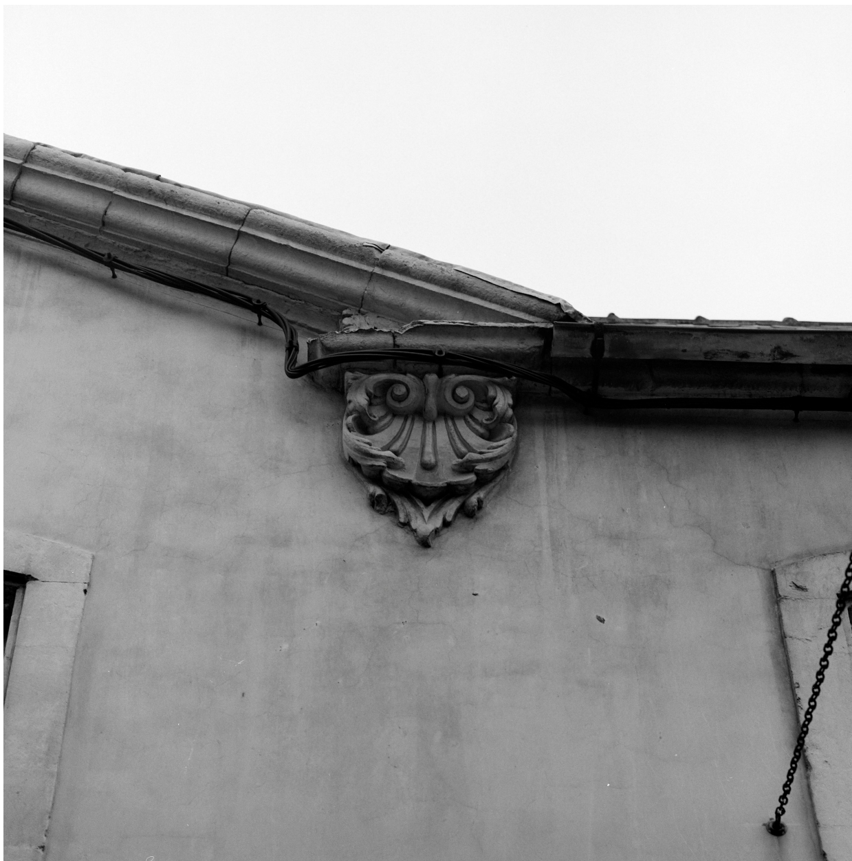
Fronton à base interrompue, console : détail droit.
