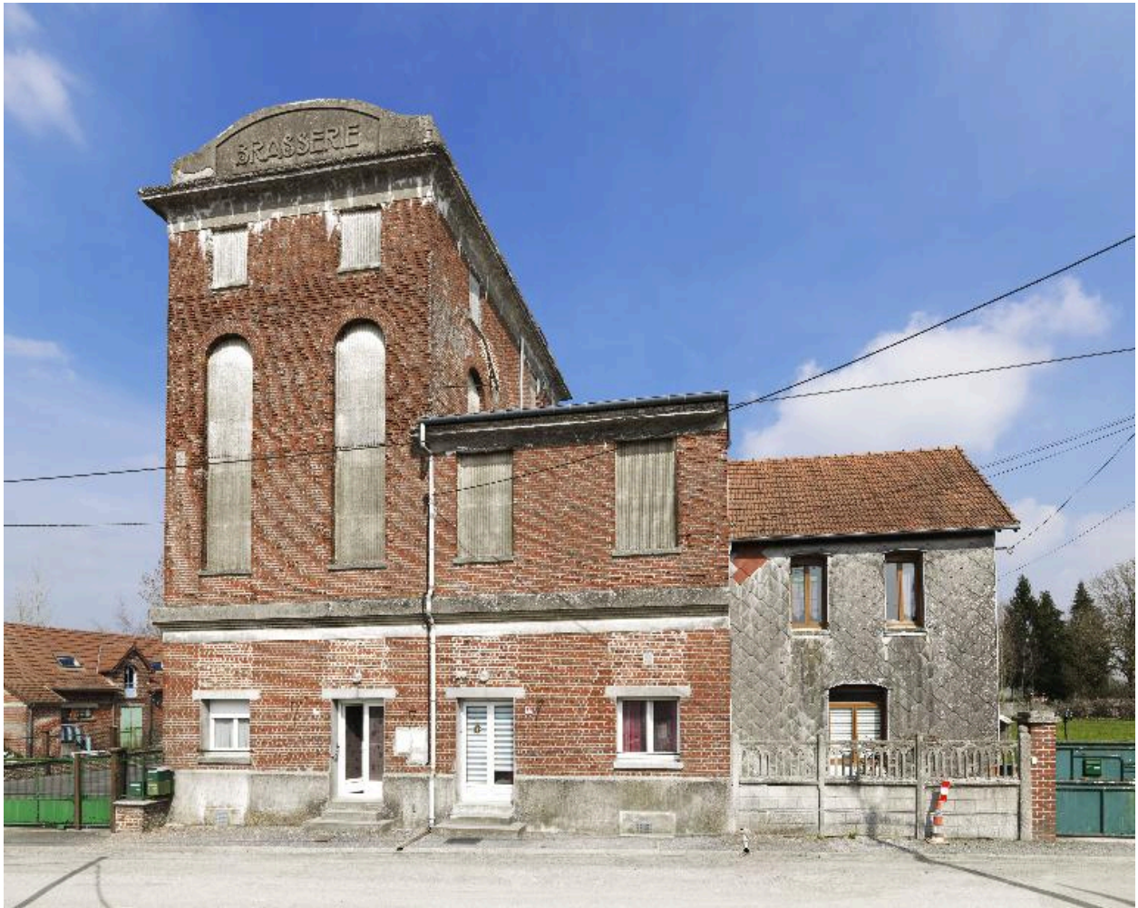
La brasserie, façade sur rue, vue de face.
