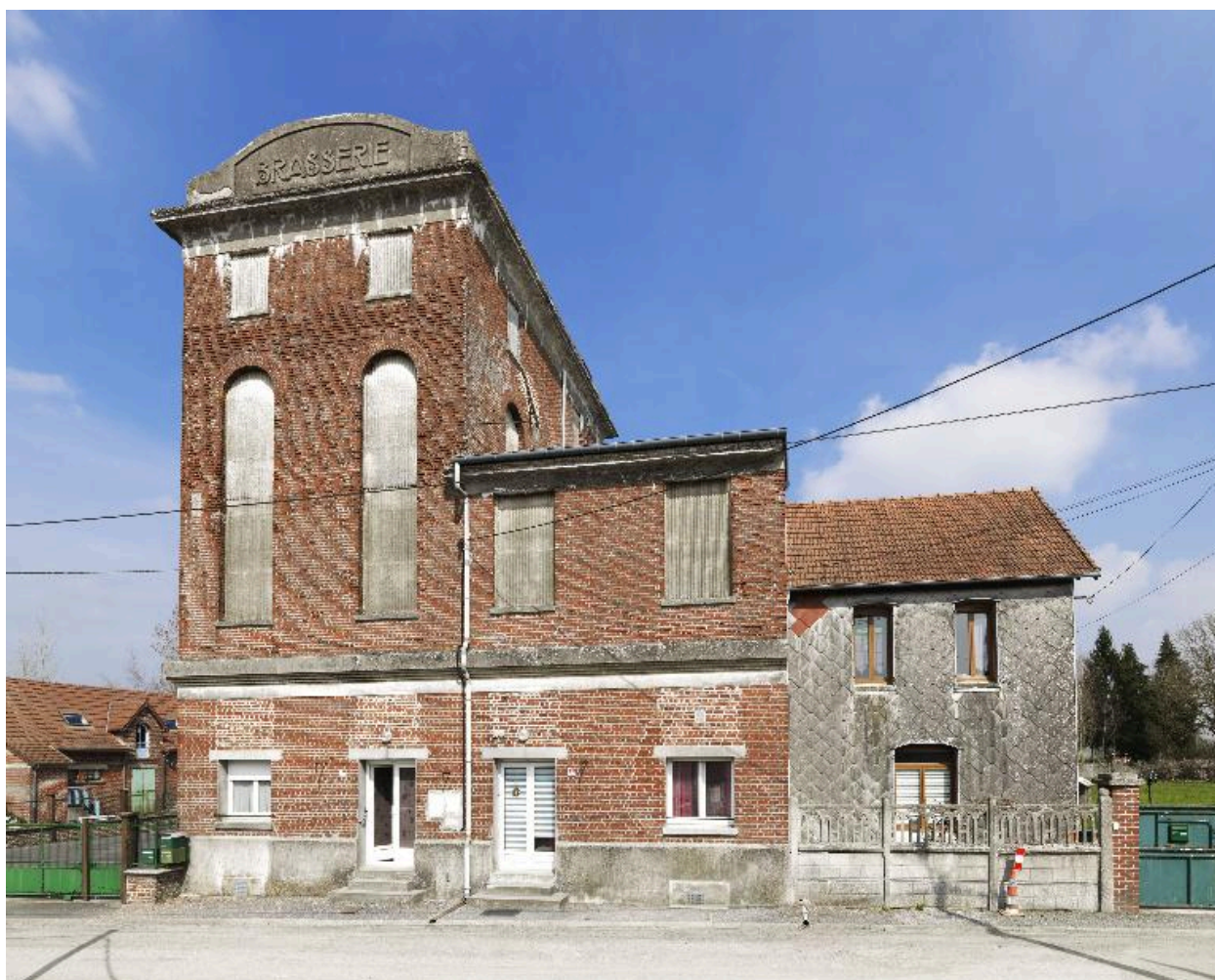
La brasserie, façade sur rue, vue de face.
