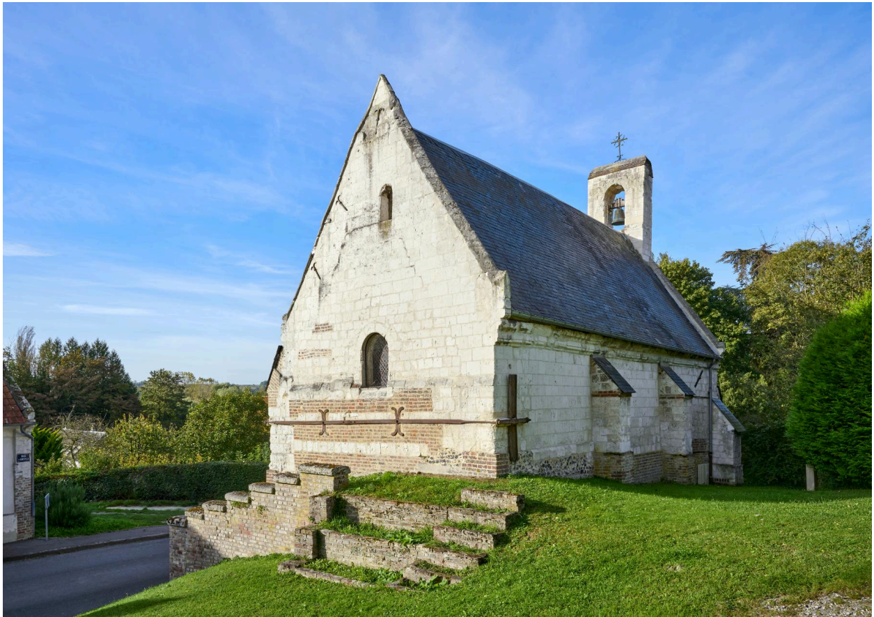
Chevet et façade nord, depuis le nord-est.
