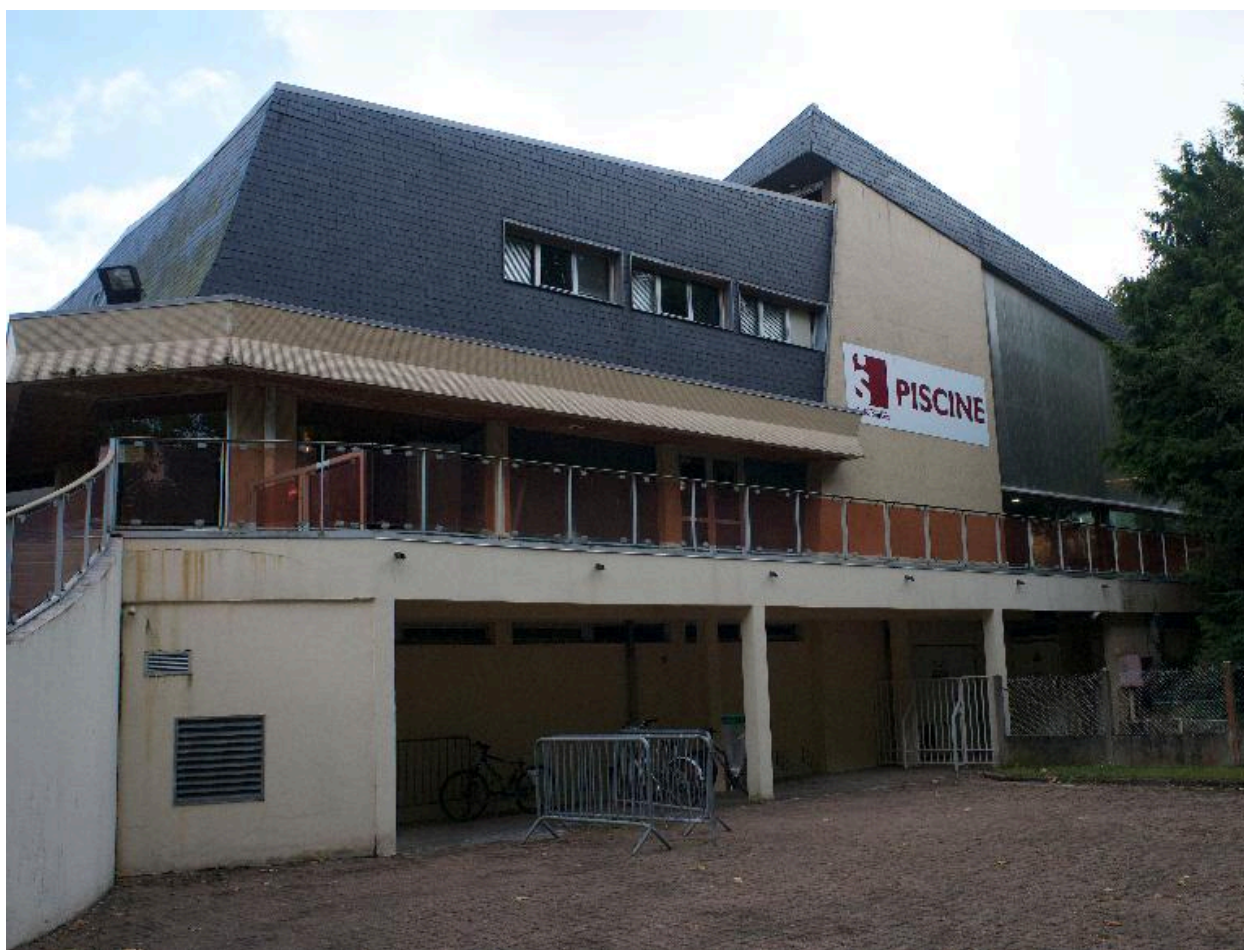
Pignon ouest (façade d'entrée).
