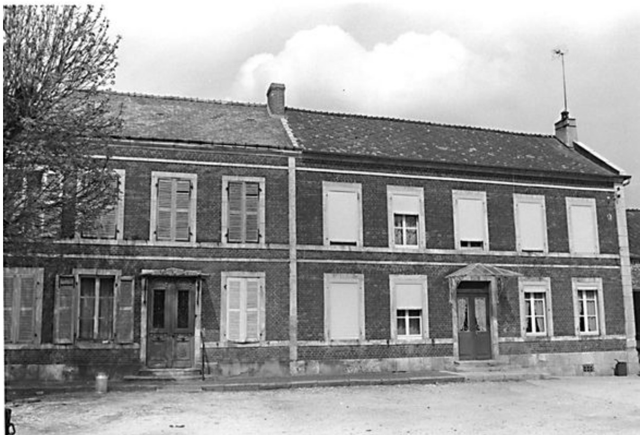
Elévation sur cour des deux logis accolés.
