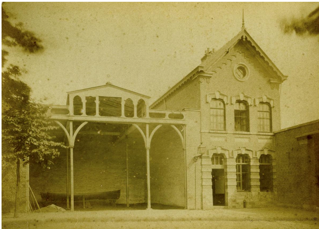
Gymnase ouvert et bâtiment de salles de classes fermant le côté de la cour. Photographie, avant 1903.
