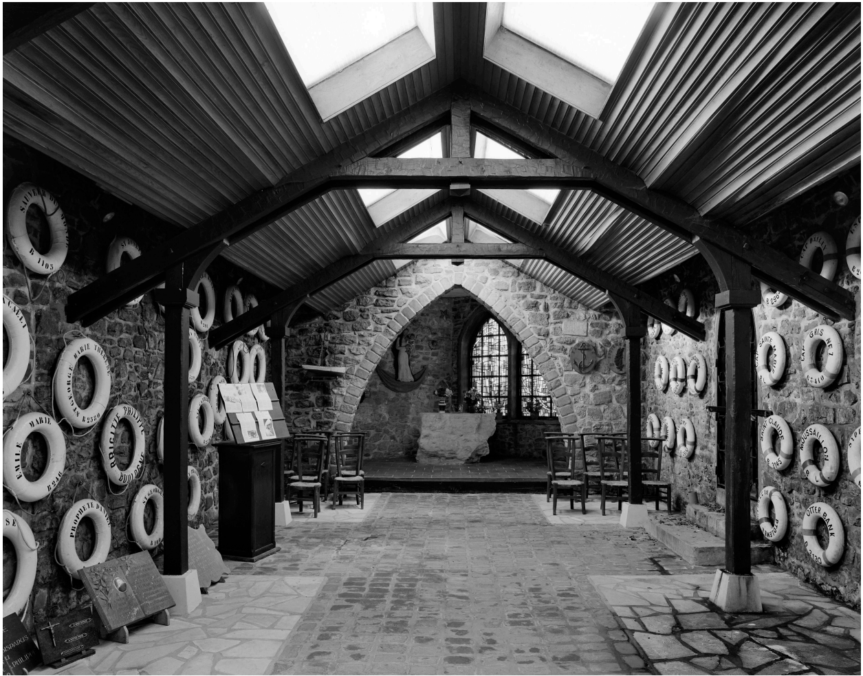
Vue générale intérieure vers autel.
