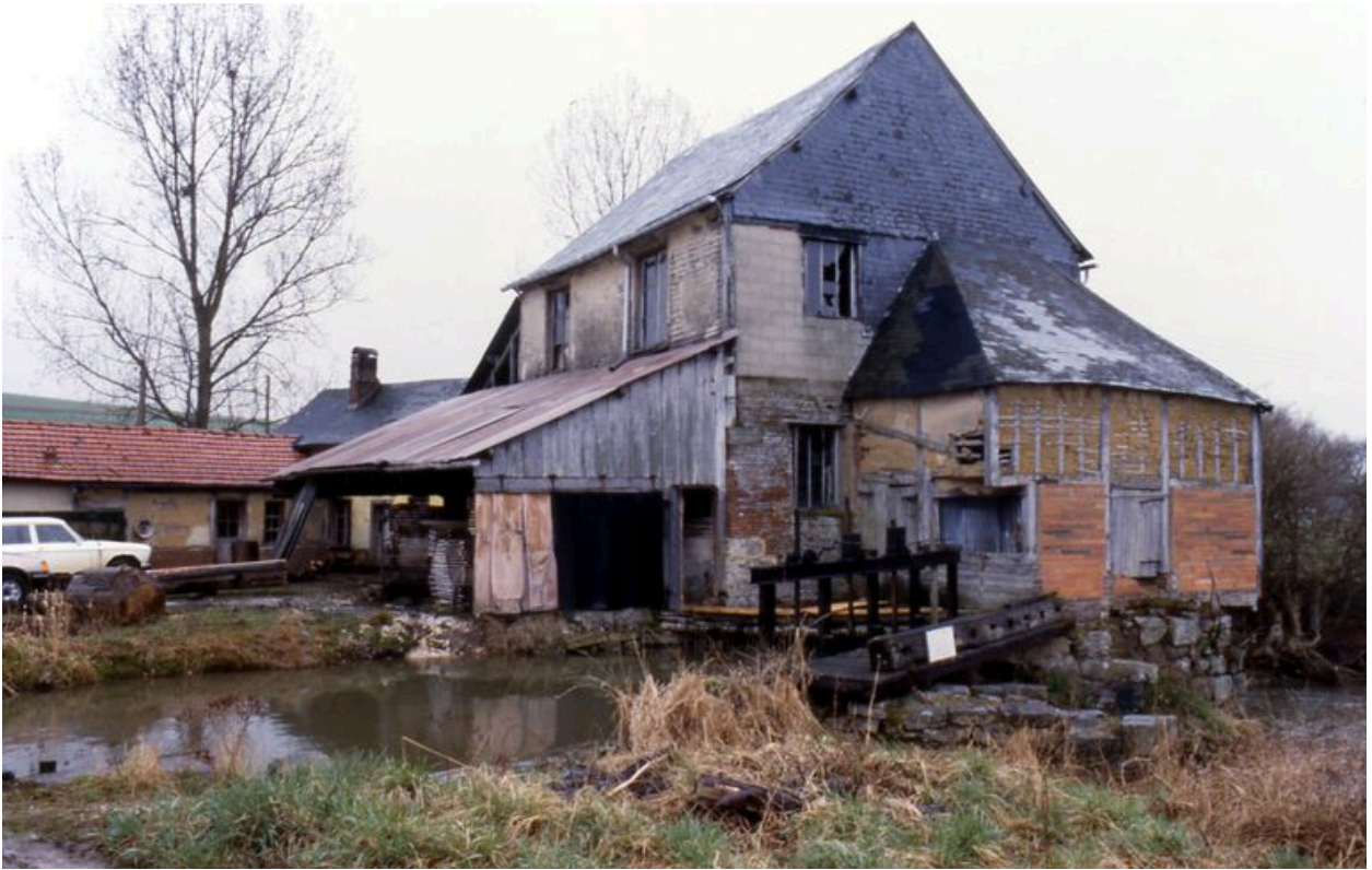
Vue d'ensemble du moulin, état en 1982.
