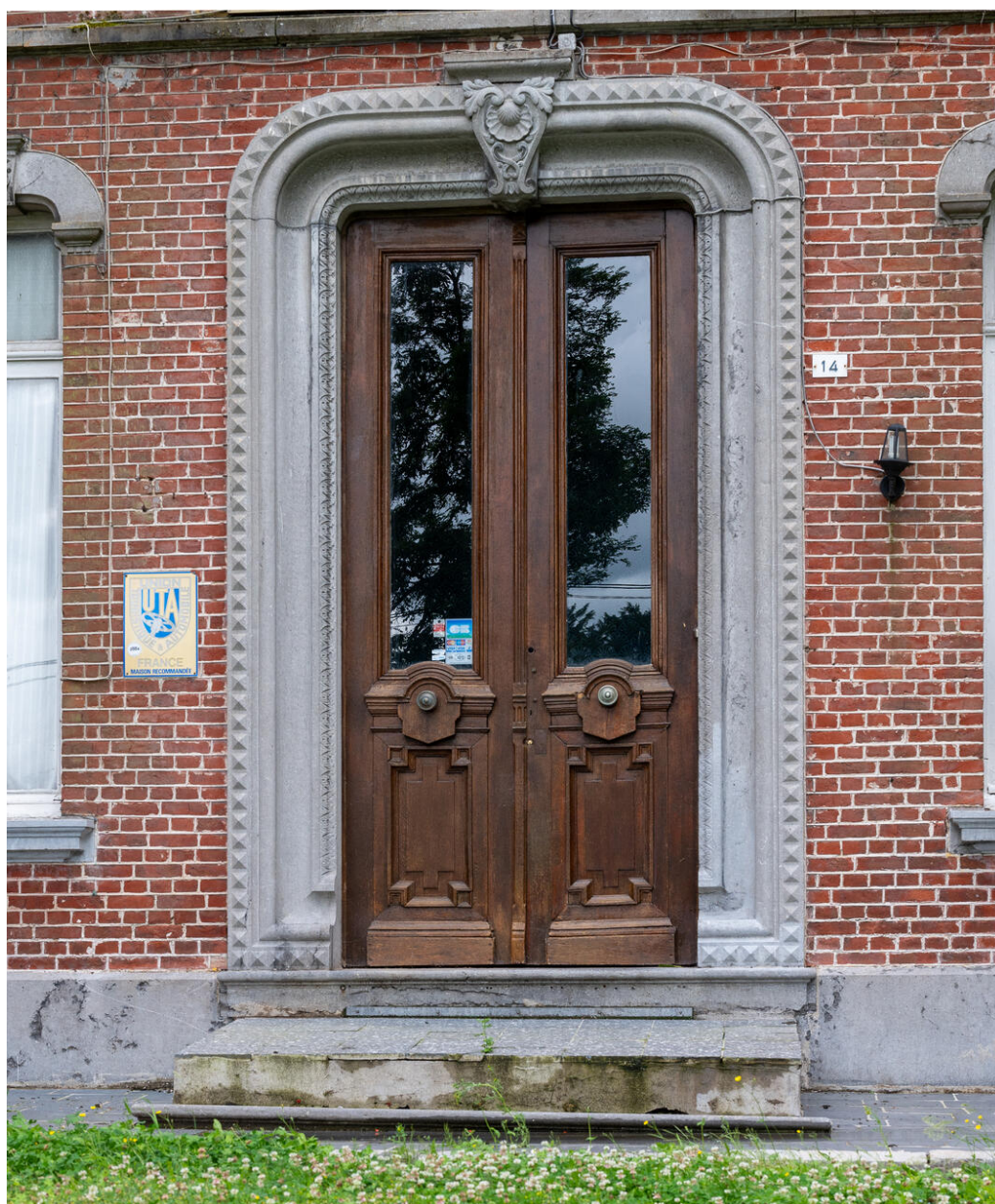
Archivolte et encadrement en pierre sculptée de l'entrée de l'élévation nord.
