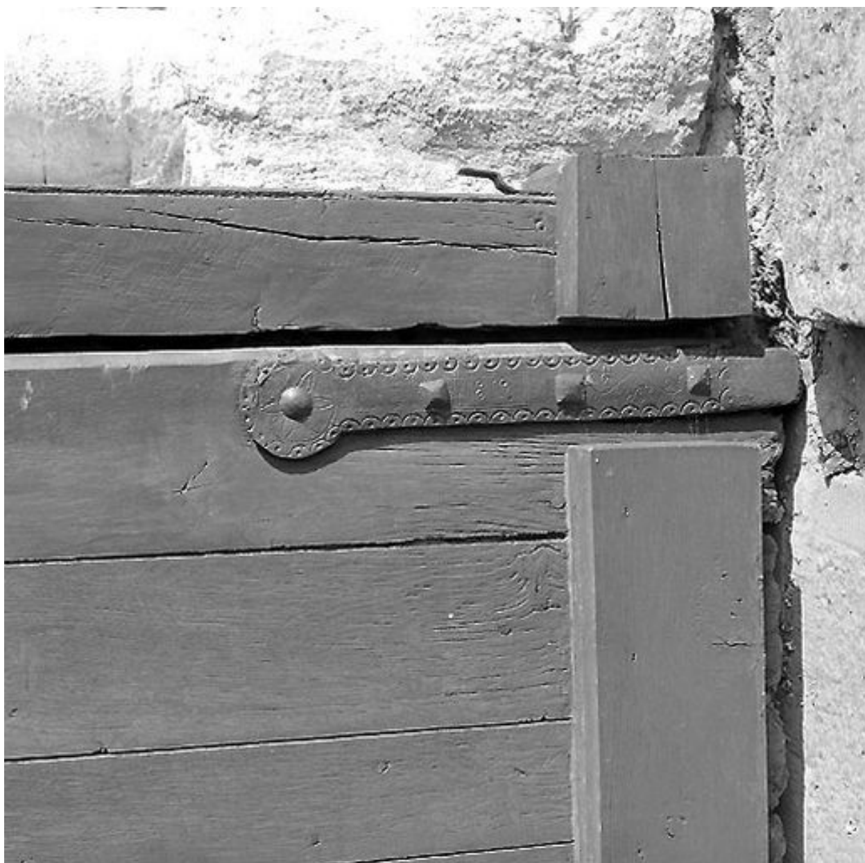
Vue d'une des deux pentures.
