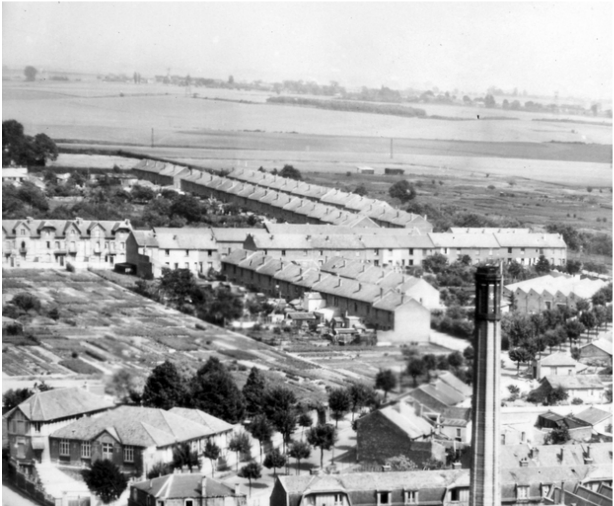
Vue aérienne, vers 1960 (AD Aisne).
