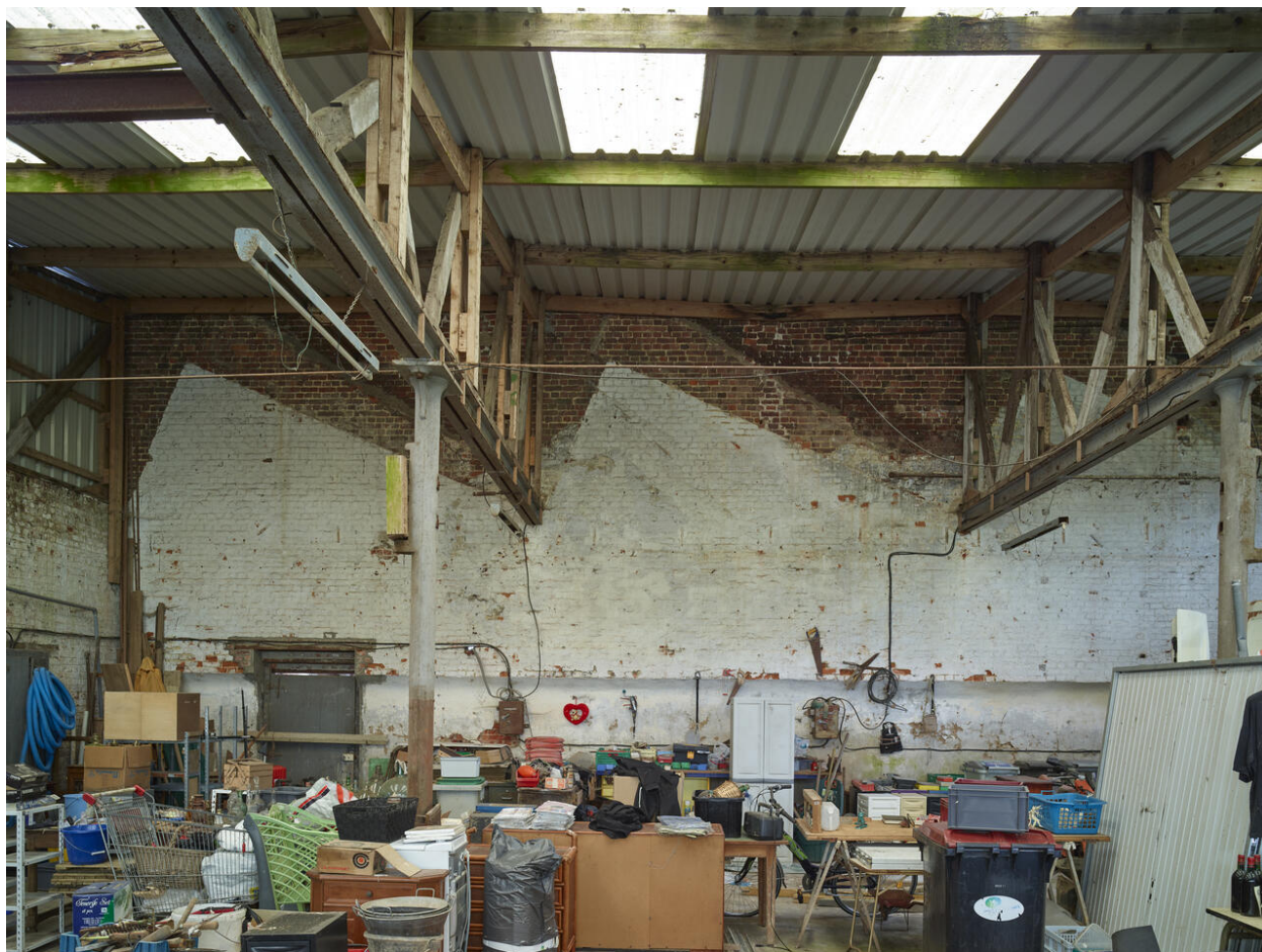
Vestiges de l'atelier de filature.
