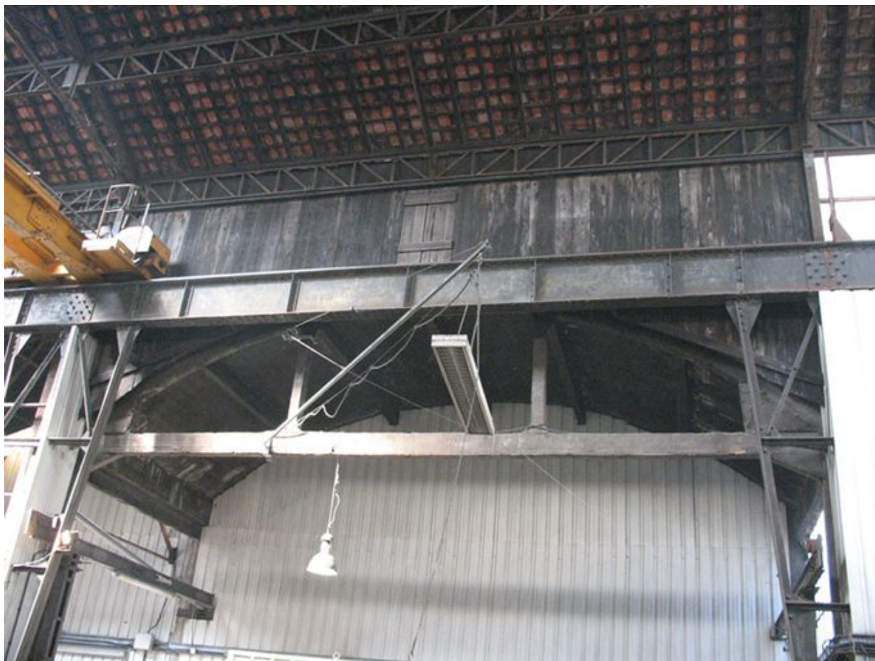
Détail des poutrelles métalliques.
