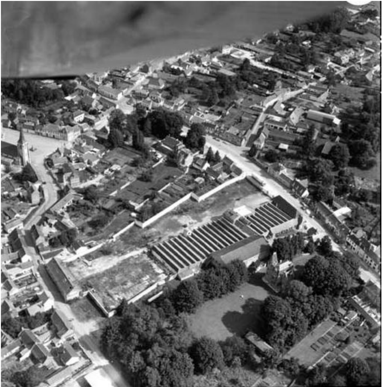
Vue aérienne partielle du village et de l'usine, flanc nord-ouest.
