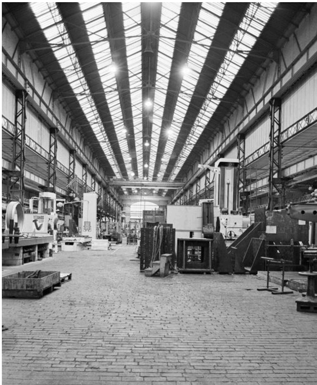
Atelier de fabrication principal : vue intérieure.
